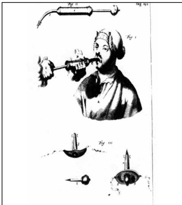
Εικόνα 2. Φυσερό για τη χορήγηση αέρα, από το βιβλίο του Friedrich Dekkers “Exercitationes practicae 1695”. Κάτω διακρίνονται οι μεταλλικοί σωλήνες για τον αερισμό μέσω τραχειοστομίας.
