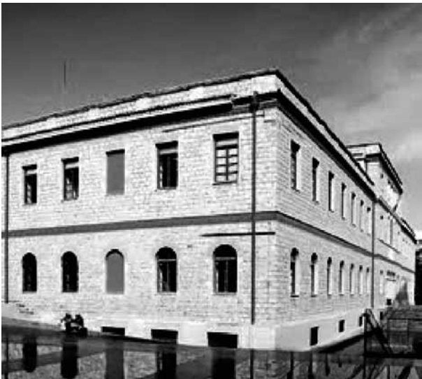
Εικόνα 1. Το πρώην Α΄ Στρατιωτικό Νοσοκομείο Αθηνών (1836-1920), στη συνέχεια κτίριο Βάιλερ ή Μακρυγιάννη, σήμερα Κέντρο Μελετών Ακρόπολης, Μακρυγιάννη 2-4, Αθήνα.
